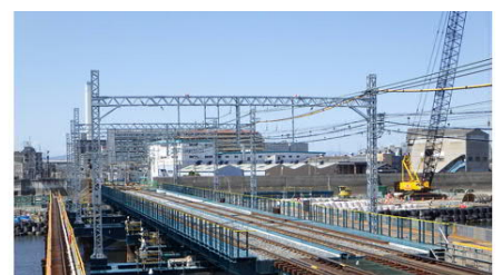
(a) 下流側既設桁撤去状況(台船使用) (b) 桁入替完了(軌道内より) (c) 桁入替完了(軌道外より)
