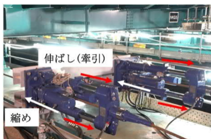
写真-1 ダブルツインジャッキ動作状況
