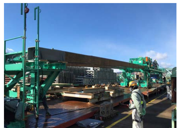
写真-3 架設機延伸状況
