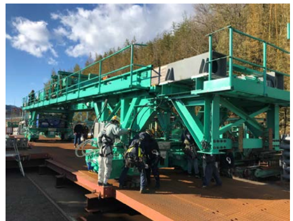
写真-2 架設機全景
