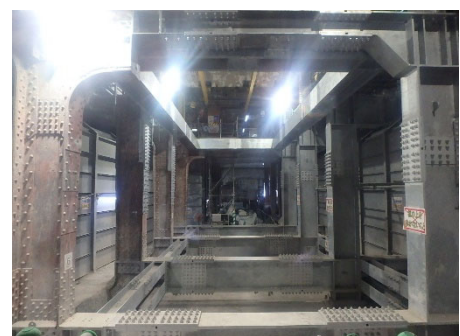
写真 2 新設構框設置完了
