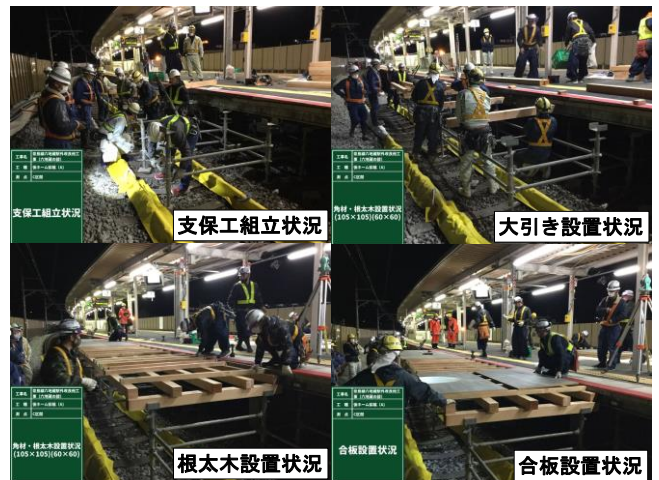
写真-1 仮組シミュレーション状況
