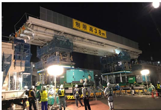
写真-2 送出し工の状況
