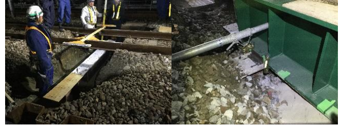
写真-1 主桁架設用受桁設置写真
