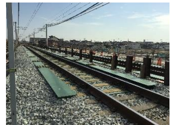
写真-2 工事桁架設完了
