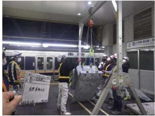
写真-5 C 型基礎積みなおし状況（下り 5 番線）
