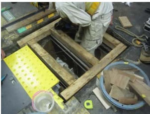
写真-1 木製覆工
