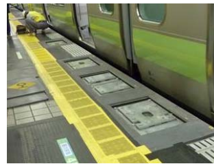
写真-3 横置き鋼製覆工板
