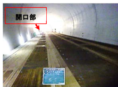
図-1-2 路面仮覆工の施工後
