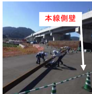
図-6 試験施工状況
