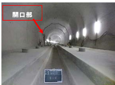
図-1-1 路面仮覆工の施工前
