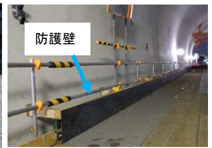
図-9 レールの曲がりを規制する防護壁の設置
