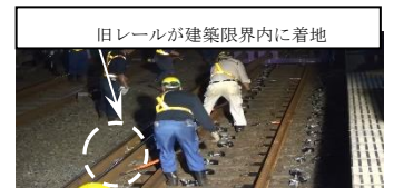
図-5 TYPE II 旧レール排出状況
