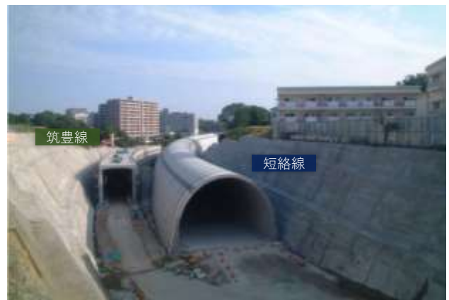
図-1 開削でのトンネル敷設状況
