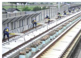
写真-1 山越器による作業
