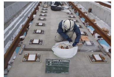
（写真-1）オープン式袋設置状況
