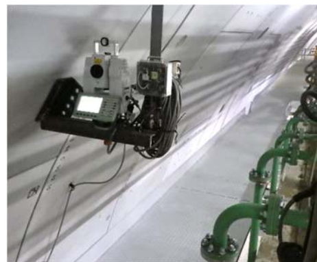
写真-1 トータルステーション配置状況
