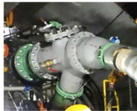
写真-1 混合槽設置状況
