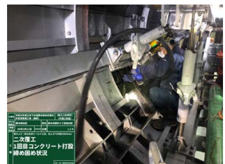
写真-1 二次覆工打設状況
