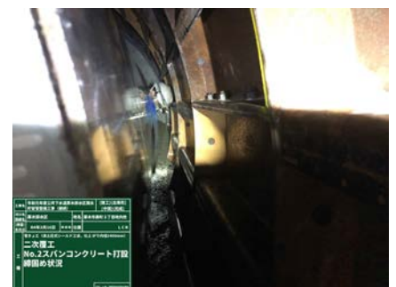
写真-2 二次覆工締め固め状況
