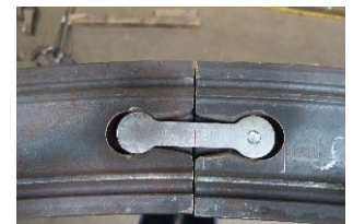
写真-2 ダンベル継手 (接続後)
