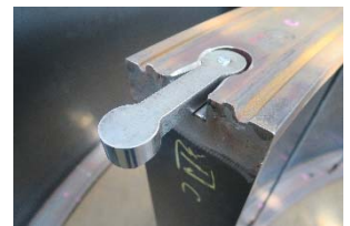
写真-1 ダンベル継手 (接続前)
