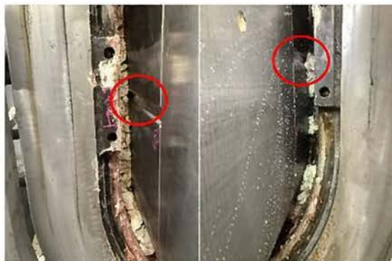
写真-1 縦溝通過状況
