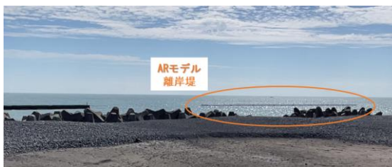
図-5 離岸堤完成イメージモデルの投影状況
