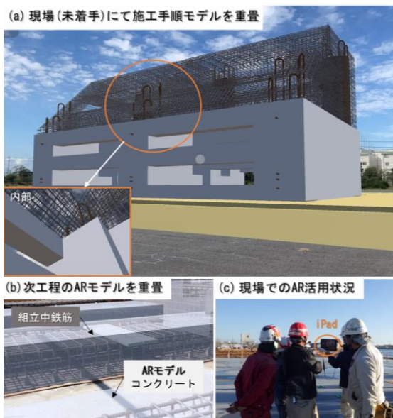
図-4 函体製作現場でのAR活用状況
