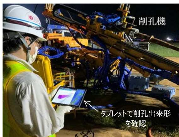
図-5 タブレットから削孔出来形を確認
