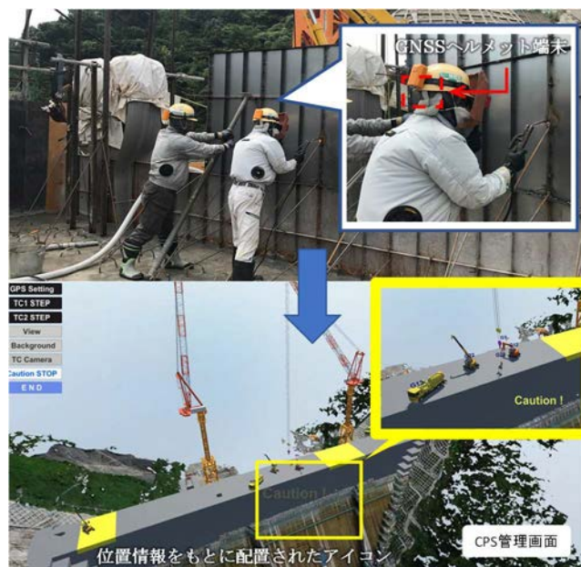
図-2 GNSS 端末使用状況と CPS 管理画面
