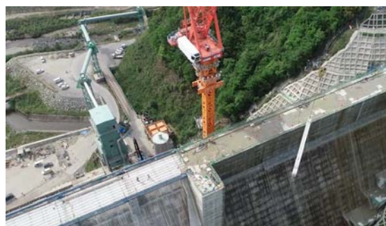
図-5 実際の現場状況
