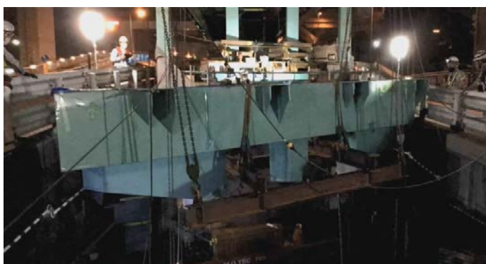
写真-3 施工状況 (4段目新設支柱吊上げ回転時)
