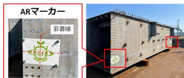
図2 主桁ブロックへのマーカー貼り付け状況
