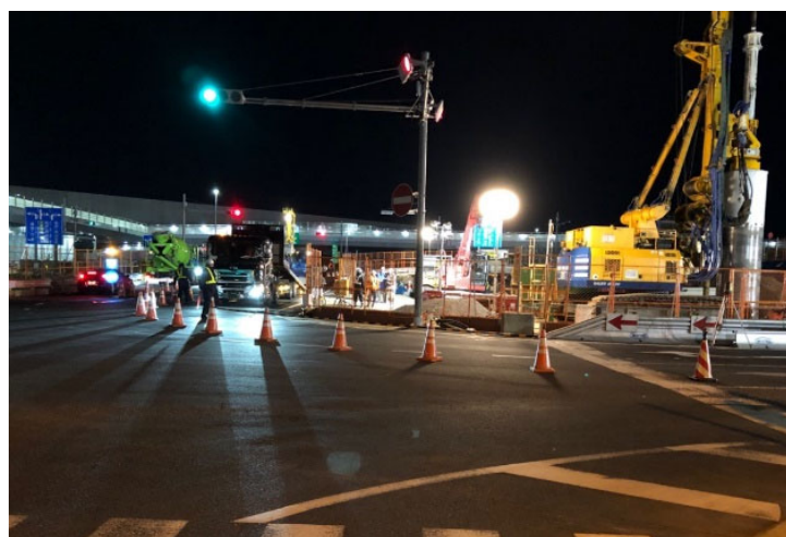
図-2 夜間作業の様子
