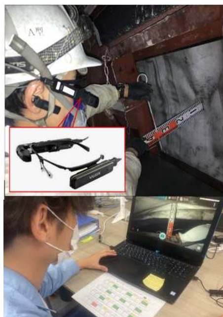
図 1 遠隔臨場による出来形検査
