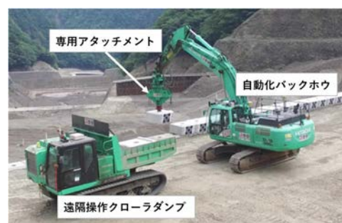
写真-1 ブロック自動据付状況
