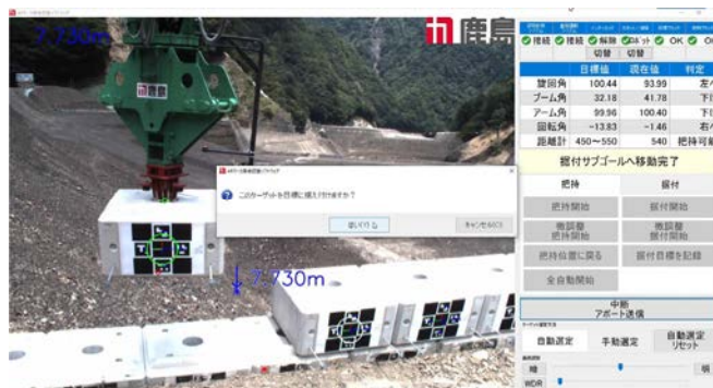
写真-3 自動運転操作画面（据付サブゴール位置）
