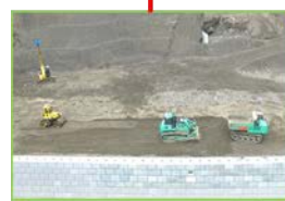
赤谷3号砂防堰堤工事 (奈良県)
