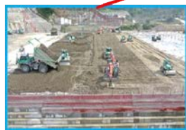
成瀬ダム堤体打設工事 (秋田県)
