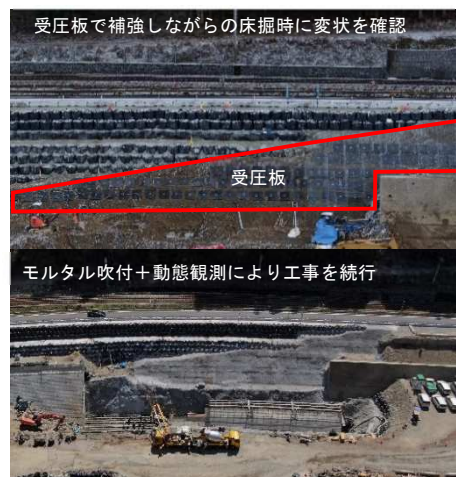
写真-3 最下流部の床掘施工状況
