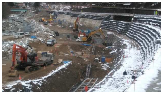
写真-2 ツボ掘り施工（分割掘削）状況
