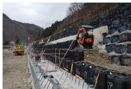
写真-6 大型土のうによる裏込め先行施工
