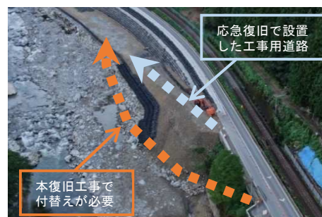
写真-4 下流側の工事用道路の位置
