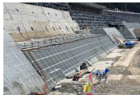
写真-5 残存化粧型枠による擁壁施工
