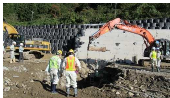
写真-1 床掘の試験施工状況
