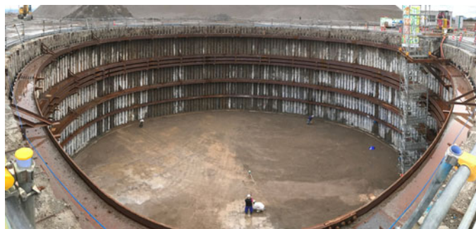
写真-1. 仮設工全景
