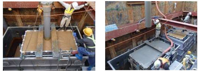
(打設状況) (打設完了)
