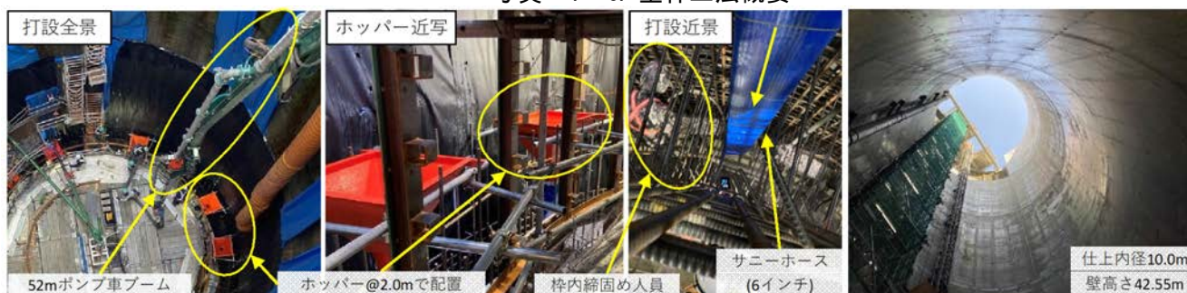
写真-2 コンクリート打設状況
