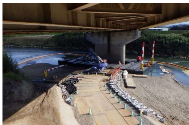
写真-2 作業台船設置状況
