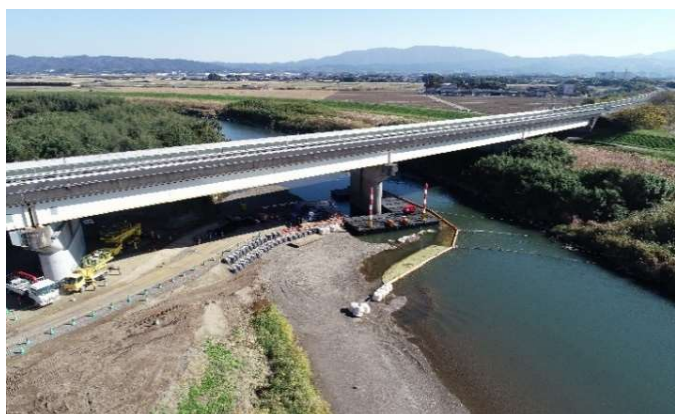
写真-1 大淀川橋の施工写真
