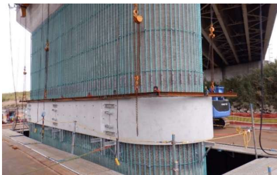
写真-3 プレキャストパネル仮設状況
