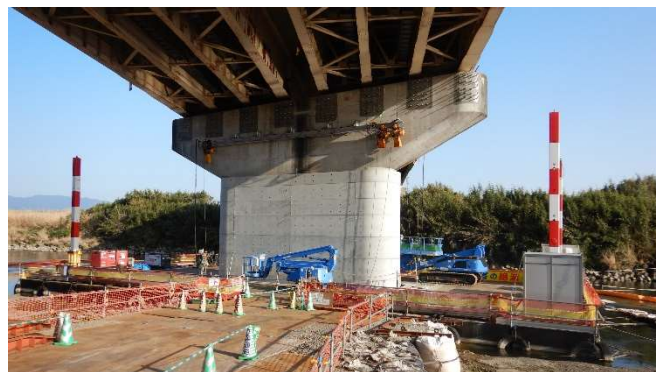
写真-5 RC巻立て後の状況
