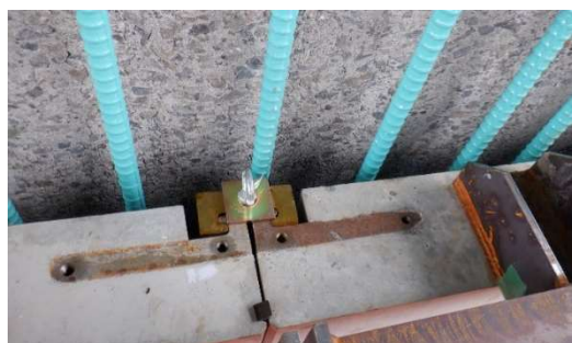
写真-4 機械式継手の差込状況
