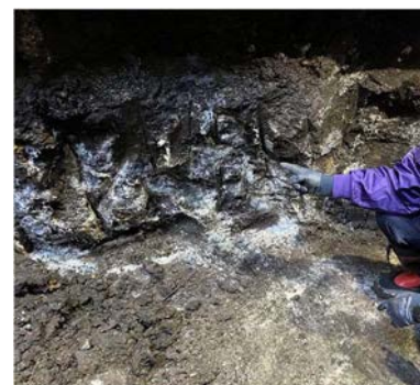
写真-3 薬液注入完了状況
