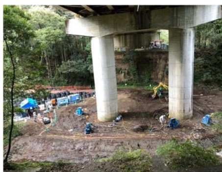
写真-2 薬液注入施工状況
