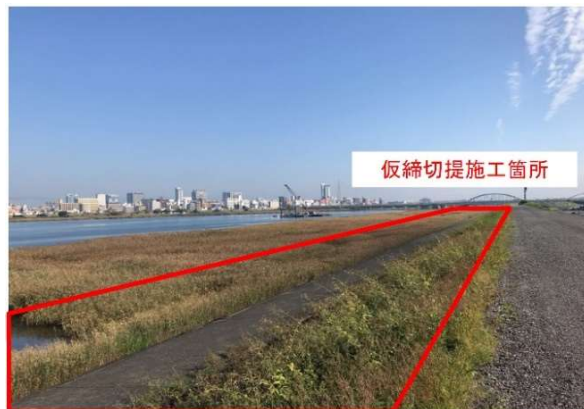
写真-1. 仮締切堤 着工前全景
