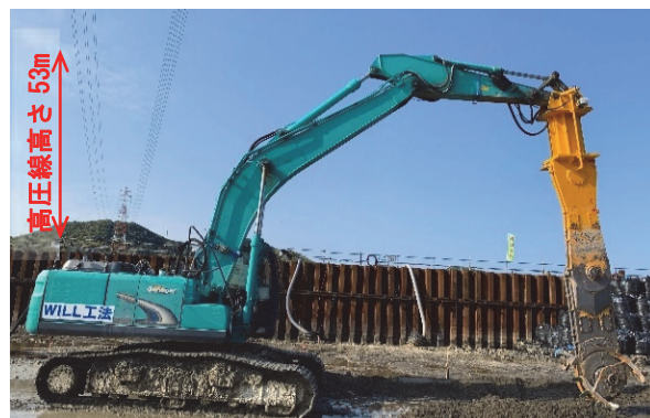
写真 1 スラリー揺動攪拌工施工状況
