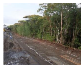
写真-1 現場状況
