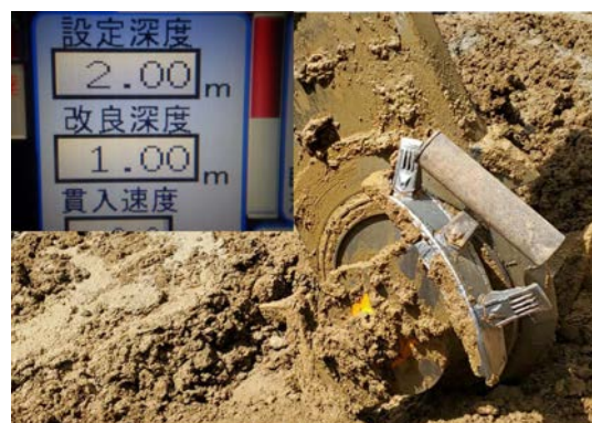
写真 2 未固結土採取器
