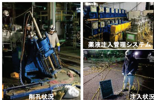
図 5 薬液注入施工状況
