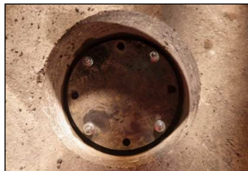
図-6 路面仮復旧用鉄板設置
