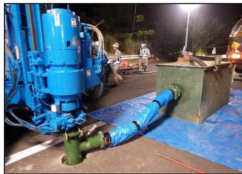
図-5 排泥回収状況
