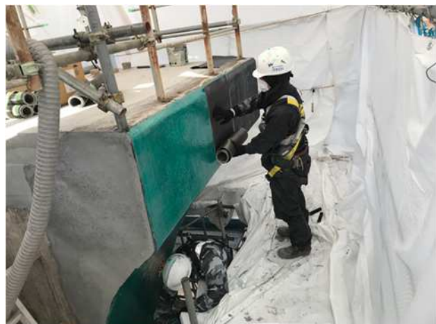
写真-2 炭素繊維補強工法施工状況
