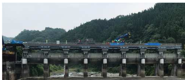
写真-3 施工状況
