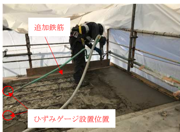
写真-1 SRS 工法施工状況
