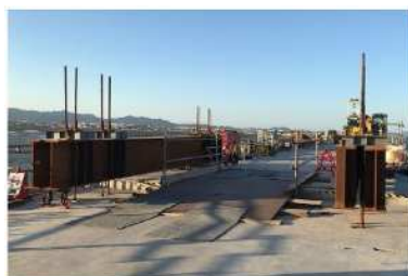
写真-1 セッティングビーム設置
