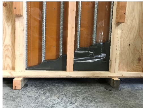
写真-1 1バッチ目打設状況
