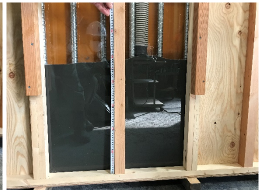
写真-2 3バッチ目打設状況
