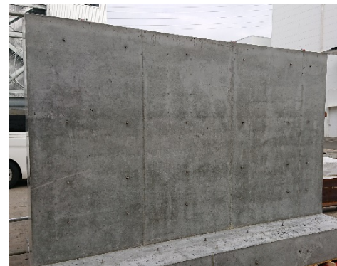
写真-2 脱型後の試験体状況
