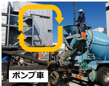
写真-1 圧送後2 試験状況
