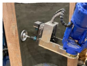
写真-5 仕上げ状況
