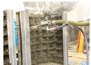
写真-4 吹付け状況
