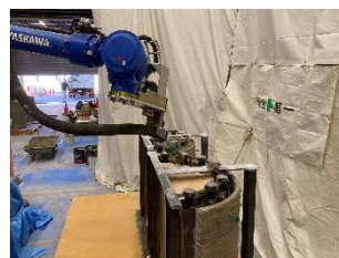
写真-7 流込み状況
