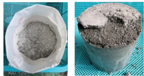
図-2 スケーリング状況 (S1-2)
