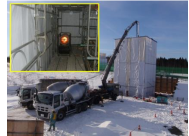
写真-1 寒中施工の様子
