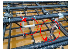
写真1 実物大高架橋 埋設センサ設置状況
