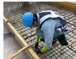
写真1 実物大高架橋 埋設センサ設置状況
