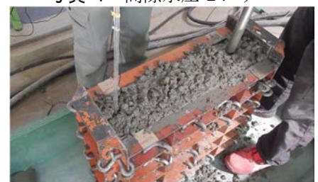
写真-2 締固め状況
