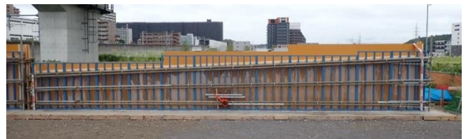
写真-1 壁状模擬型枠外観
