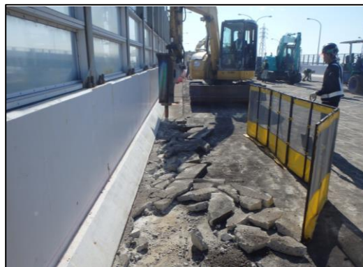
図 3 油圧ブレーカによる路肩コンクリートの撤去
